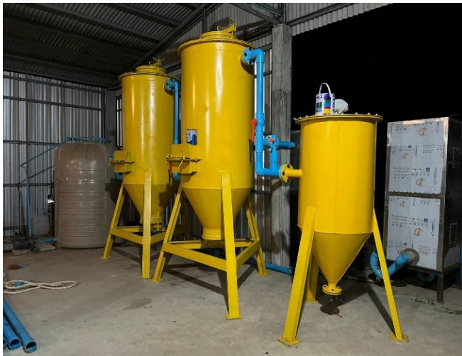
រូបភាពទី២ : ទិដ្ឋភាពនៃប្រព័ន្ធចម្រោះជីវឧស្ម័នខ្នាតធំ នៅកសិដ្ឋានចិញ្ចឹមជ្រូក ហោង មាន ក្នុងខេត្តកំពង់ធំ
